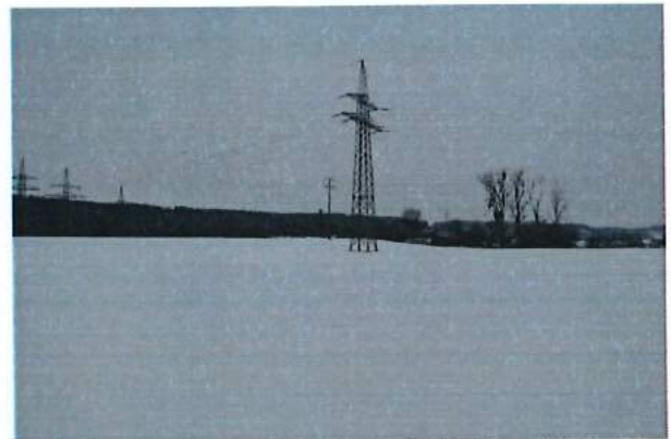
Abb. 6: Hochspannungsmasten im Süden des Plangebiets
