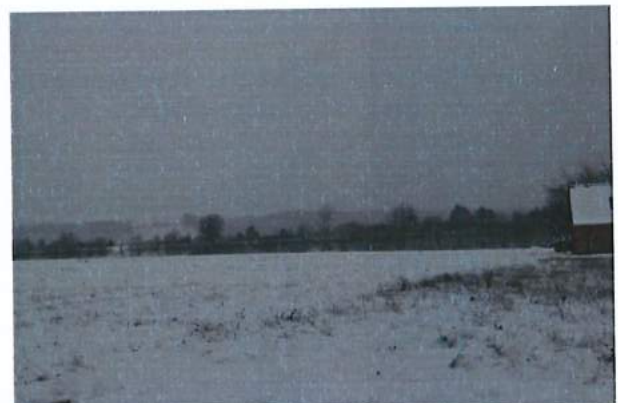
Abb. 4: Damm mit Bahnlinie
