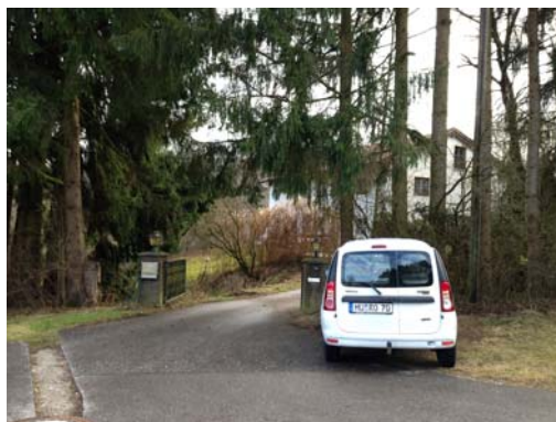
Abb. 04: Baudenkmal ehemaliges Schlosschen Hampersberg
