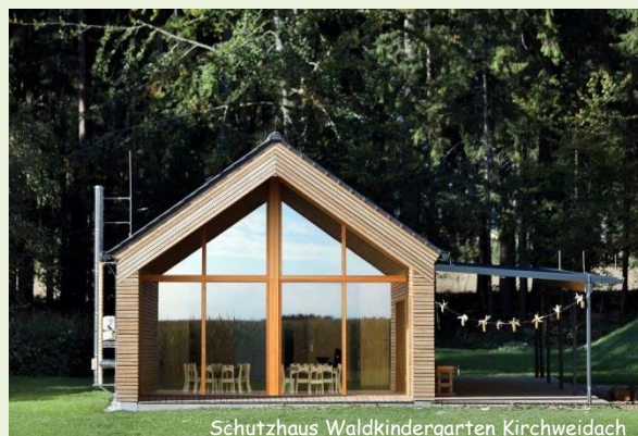
Schutzhäuser Waldkindergarten Kirchweidach
