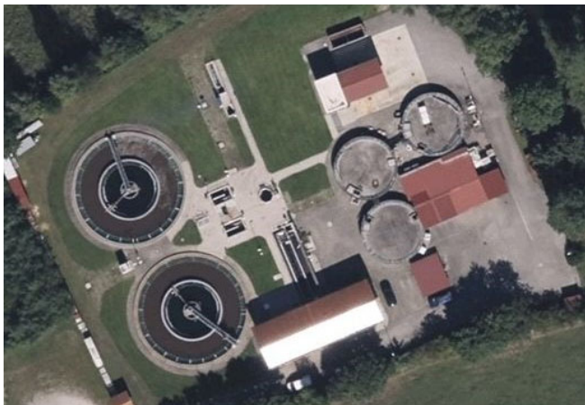
Die Kläranlage in Thal/Gars a.Inn von oben.
