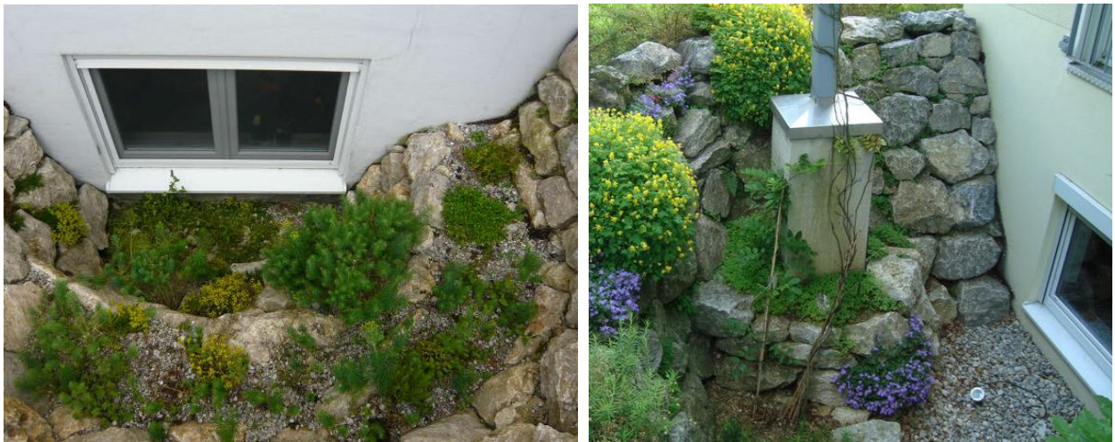
Abb. 6: Zwei Beispiele für den Bau „amphibienfreundlicher“ Kellerschächte (Fotos aus dem Internet)
